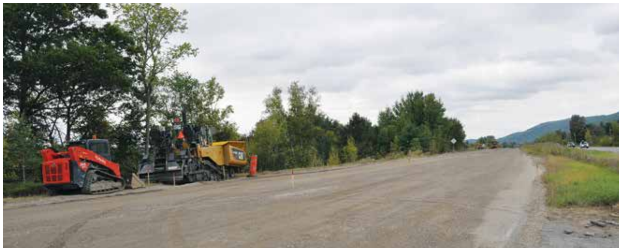
De la machinerie lourde est toujours présente aux abords de la route 148 après que le gouvernement a brusquement interrompu le projet de réasphaltage. (CH)
